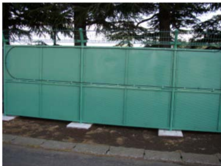
金属パネル フェンス
