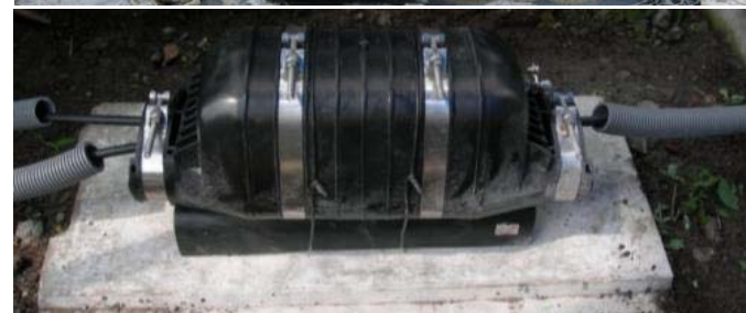
分岐結合器 の組立て・固定
