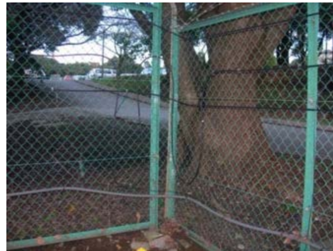
ネットフェンス 曲がり部
